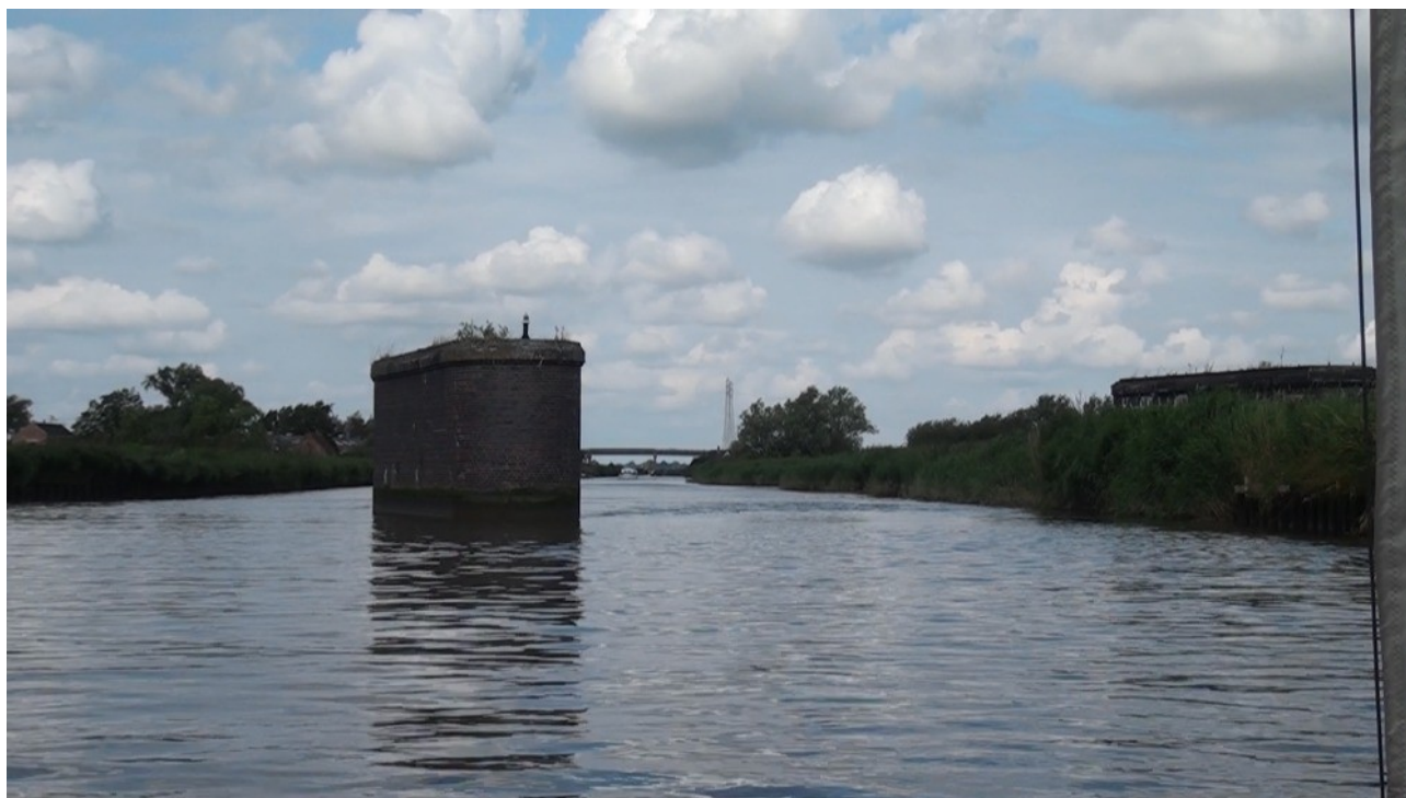
Pilíř původní železniční tratě
